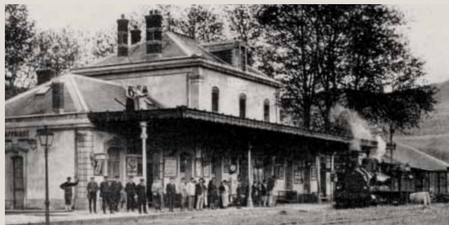
Sur les quais de la gare de Saint-Affrique
