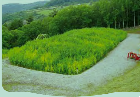
Épuration des eaux usées à Castelnau-Pégayrols (filtre à sable planté de roseaux)
