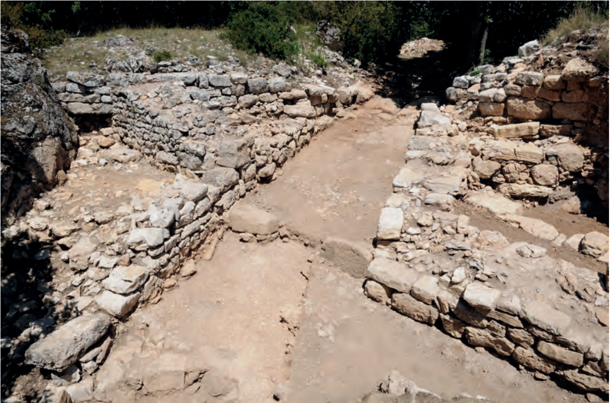
51 > Secteur à l'entrée du site, vue du chemin d'accès et des deux blocs de grès réutilisés pour former les crapaudines de la porte d'entrée.
