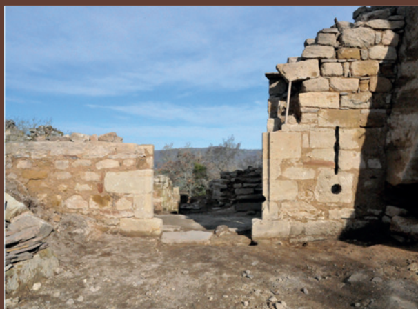
Porte d'accès depuis la plateforme de la chapelle
