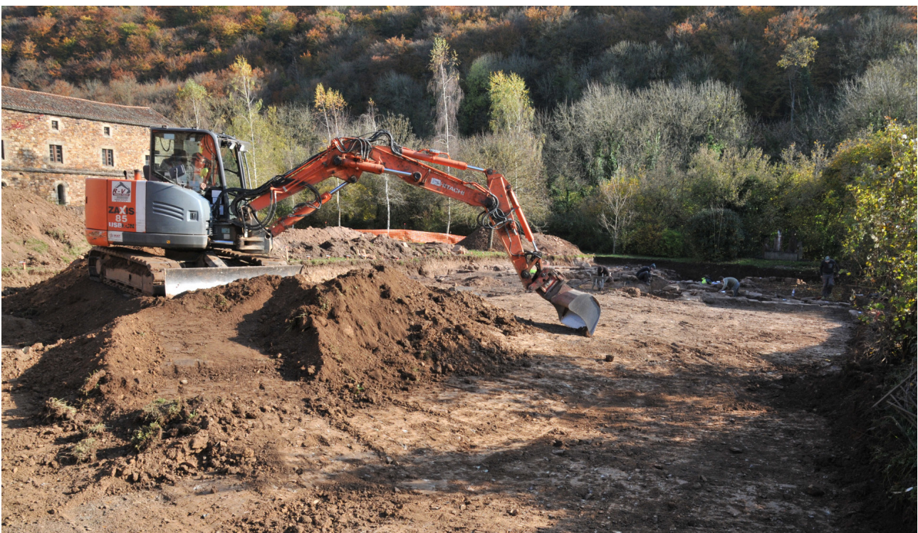
Fig. 1 : Décapage mécanique de la surface (cliché Christophe Saint-Pierre).
