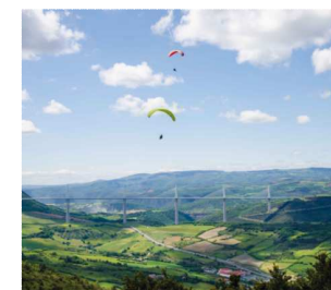
Viaduc de Millau
