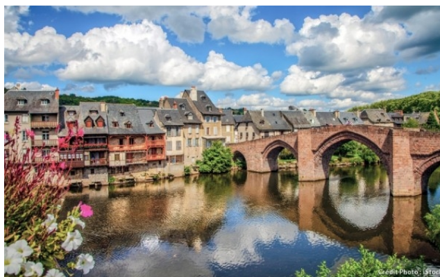
Figure 5: Le Pont Vieux et les anciennes Tanneries sur le Lot.
