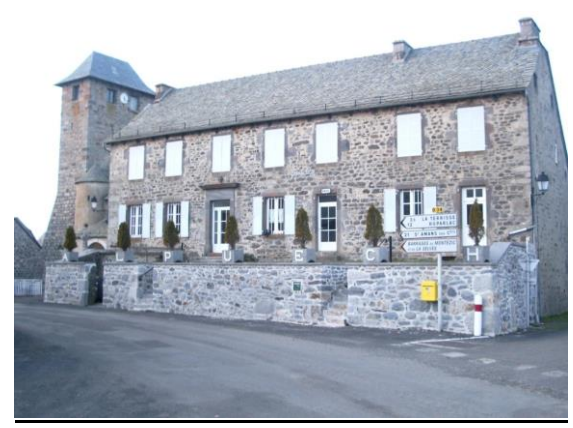
Vue de l'ensemble du bâtiment – cœur du bourg
