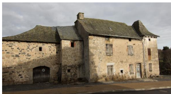
Bâtiment à restaurer – Office de Tourisme et espace d'accueil
