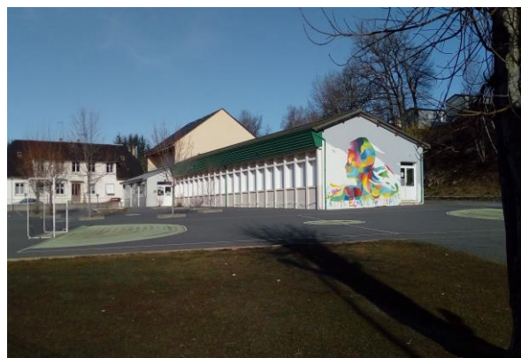
Ecole du bourg centre – travaux d'isolation et de modification du système de chauffage :
