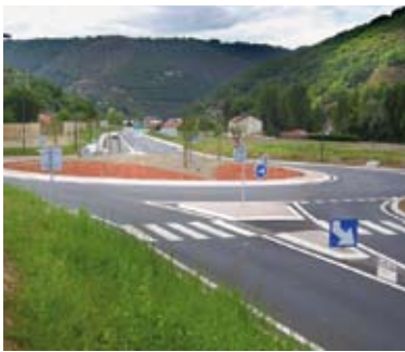
La déviation de Viviez a été équipée de revêtement phonique
