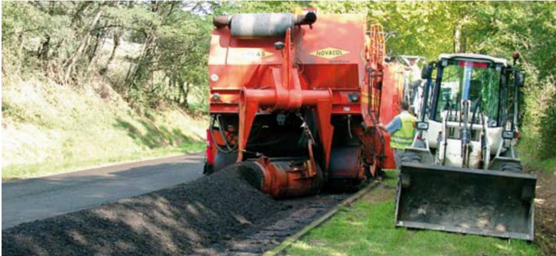
Une application très concrète avec les technologies utilisées sur les routes départementales
