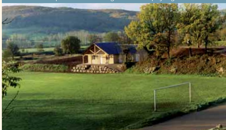
Légèrement surélevés et couverts de lauzes de pays, les nouveaux vestiaires sont parfaitement intégrés dans le paysage.
