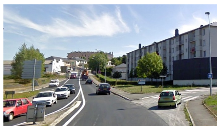
RD 840 avenue de la Gineste à Rodez
