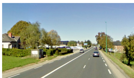
RD 888 - Avenue de Rodez hors agglomération sur Luc-La-Primaube
